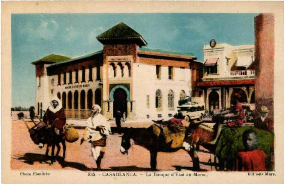
Le bâtiment de la Banque d'Etat du Maroc, d'après une carte postale d'époque.
