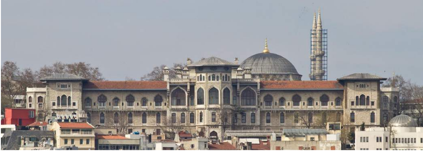
Le bâtiment de l'ADPO à Istanbul, qui abrite aujourd'hui l' Istanbul Erkek Lisesi , l'un des plus prestigieux lycées de la ville.
